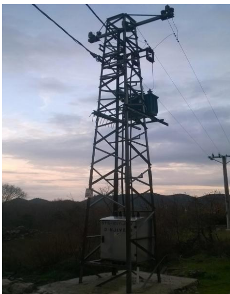
Slika 6.5. ZTS DUGE NJIVE RADALJI 10/0,4 kV
