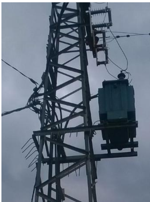
Slika 6.49.TS VIŠNJICA 10/0,4kV
