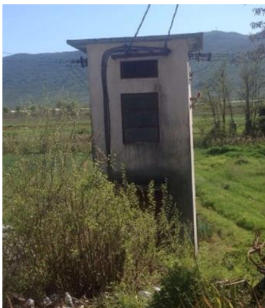
Slika 6.37. TS ORAH 1 10/0,4kV
