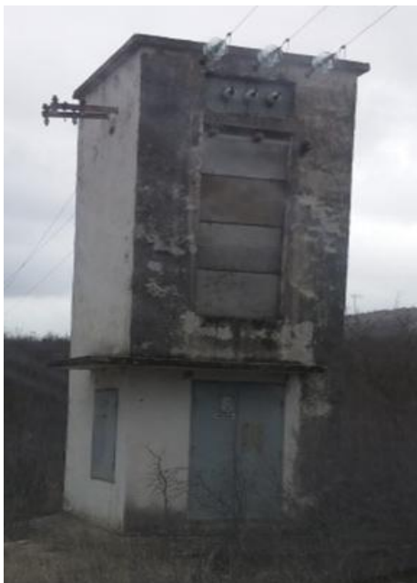
Slika 6.57. TS VRGORACKA POLJICA 2 10/0,4kV
