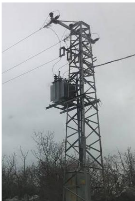
Slika 6.59. TS VRGORACKA POLJICA 4 10/0,4kV
