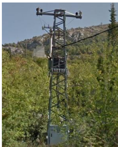
Slika 6.27. TS LUKAVAC 10/0,4kV
