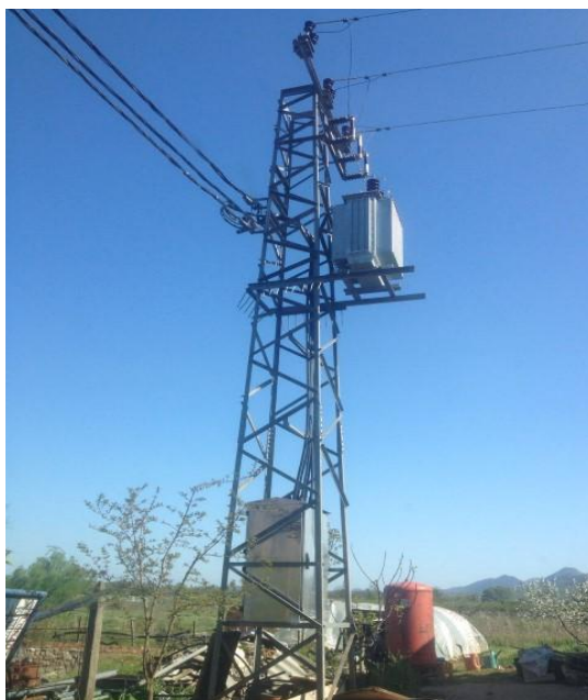
Slika 6.39. TS ORAH 3 10/0,4kV
