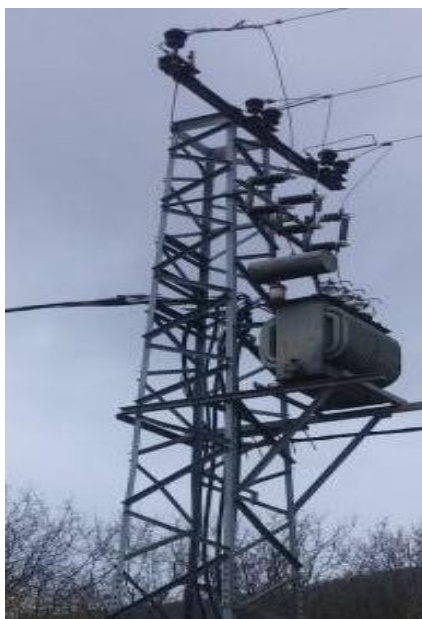
Slika 6.56. TS VRGORACKA POLJICA 1 10/0,4kV
