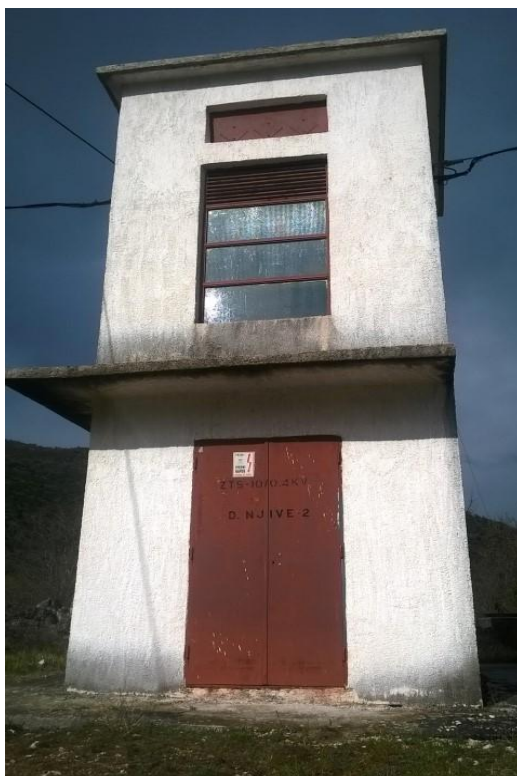
Slika 6.4.ZTS DUGE NJIVE 2 10/0,4 kV
